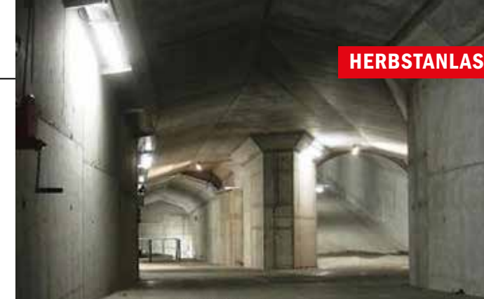
Am tiefsten Punkt des Stollens trifft der Zugangsstollen (rechts Richtung Ausfahrt) auf den Entwässerungsstollen (Standort Fotograf).
