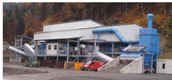
Die neue Entschrottungsanlage. Sie ist 60 Meter lang, 20 Meter breit und so hoch wie ein vierstöckiges Haus.
